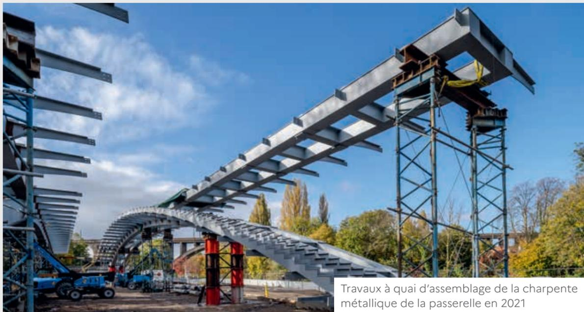
Travaux à quai d'assemblage de la charpente métallique de la passerelle en 2021
